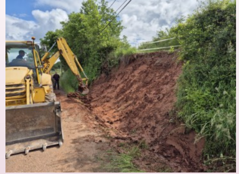
Travaux de voirie et de renforcement de talus sur la route de Cantuel.
